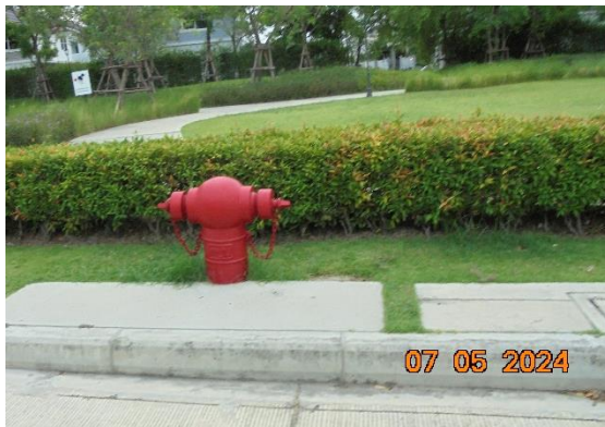
รูปที่ ก-16 หัวดับเพลิง (Fire Hydrant) ที่ได้ติดตั้งในพื้นที่ 1
